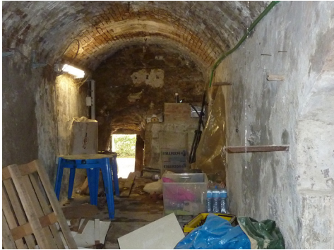
Fig. 6- Veduta della galleria del fianco sud-est (foto di Roberto Castiglia)
