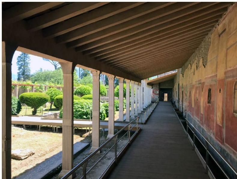
Fig. 5 - Parco Archeologico di Pompei, Casa di Iulia Felix (II 4). Tramite il sistema di passerelle interne, posto a protezione dei pavimenti, il percorso di fruizione della domus si riconnette al percorso accessibile Pompei per tutti .
