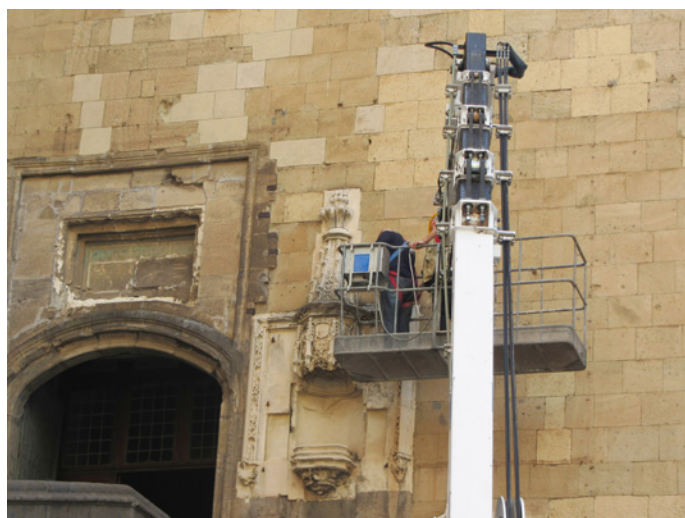
Fig. 4. La cortina est. Particolare dei prelievi sul paramento in tufo.
