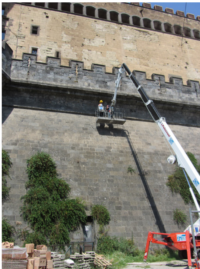
Fig. 1. I prelievi eseguiti sulla facciata meridionale.
