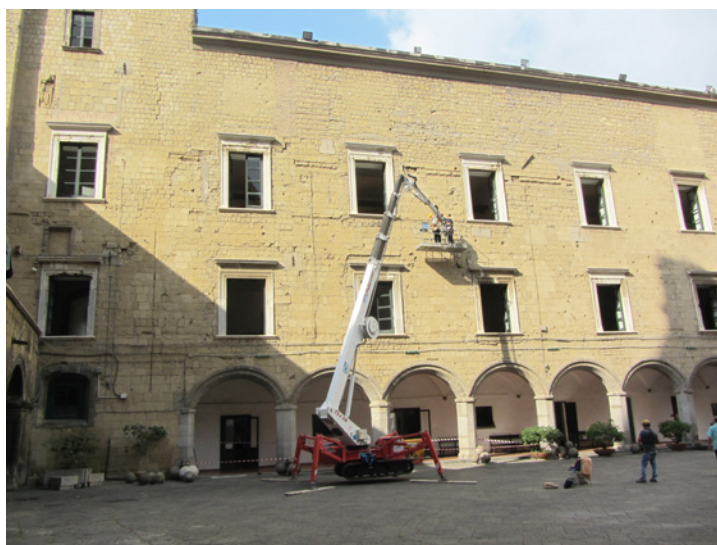
Fig. 5. La cortina sud. Particolare dei prelievi per le campionature.
