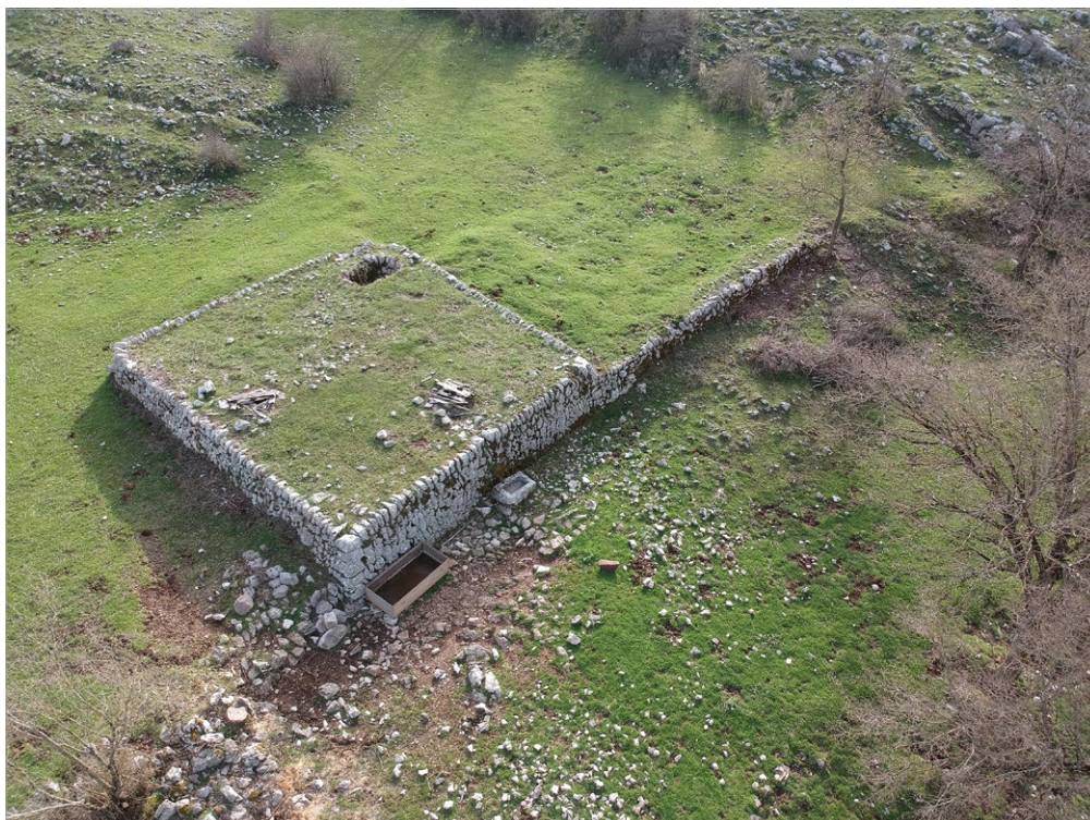
fig. 3 – La cisterna CPV 115. Sono visibili a destra il muro che chiude il terrazzamento e l'opera d'invaso posta nell'angolo sud-ovest della cisterna, in corrispondenza del vano a cielo aperto.
