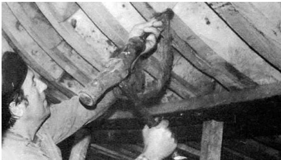
Fig. 24 - Scena di calafataggio nel porto di Fano; inizi del '900 (per concessione dell'Associazione di volontariato e solidarietà "Il ridosso").
