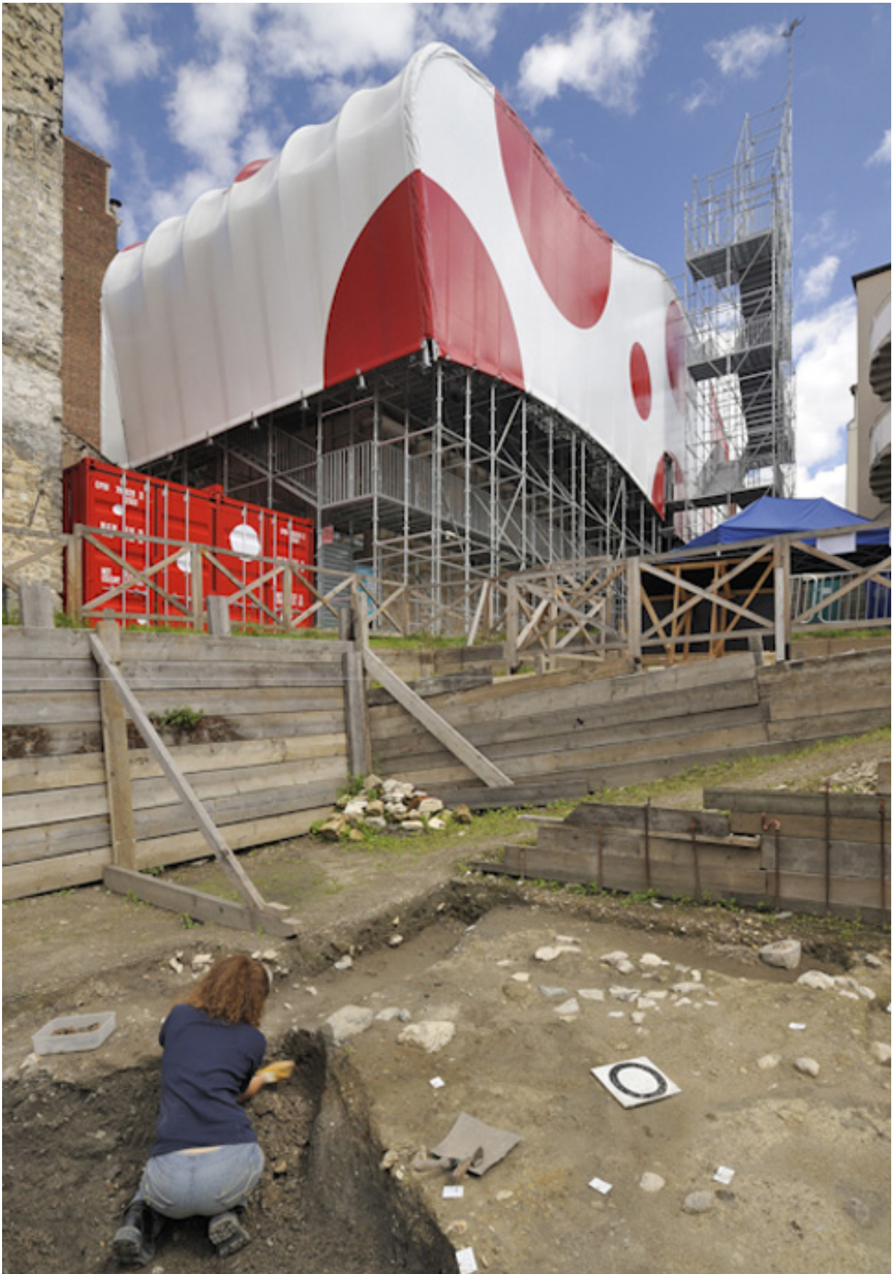
Fig.3 - St. Denis, France. La "Fabrique de la ville", il cantiere di scavo di archeologia preventiva dell'îlot Cygne e la sistemazione -ricostruzione di una delle due case medioevali recuperate. (Photo: ©Pierre Buch)
