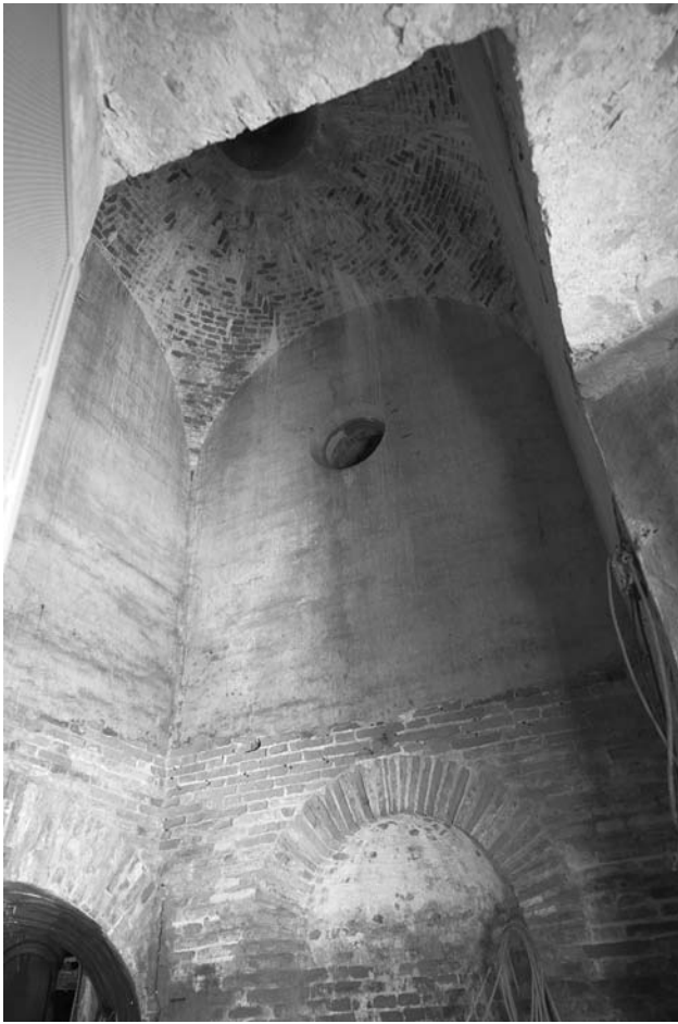
Figure 19 Small cupola with octagonal oculus in the underground chambers of the bastion of San Martino, Pisa (photo by Laboratorio Fotografico del Dipartimento di Civiltà e Forme del Sapere, Università di Pisa, 2014).
