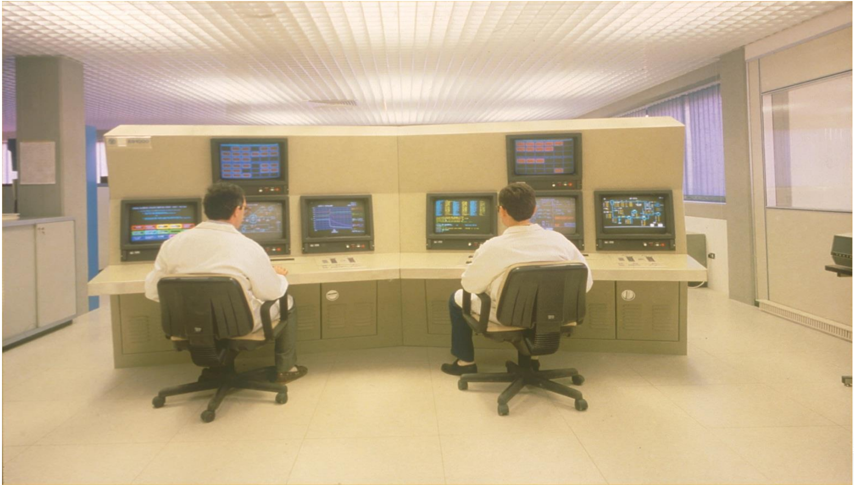
Westinghouse-ENEA ES-1000 (ENEA Casaccia – 1986-1990)
