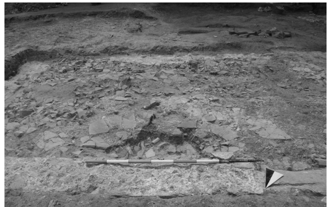
Fig. 7. Piano pavimentale in tegole fratte, adiacente al muro perimetrale nord dell'ambiente 9 (saggio CXI).
