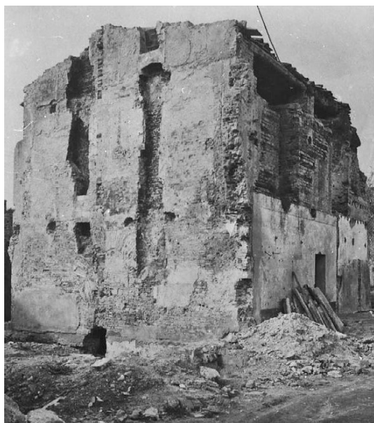
5 Pisae (Pisa). Terme di Nerone. La sala ottagonata durante i lavori di abbattimento degli edifici moderni nel 1940 (SBAAAS-PI, 157645, da Pasquinucci, Menchelli 1989, fig. 43).
