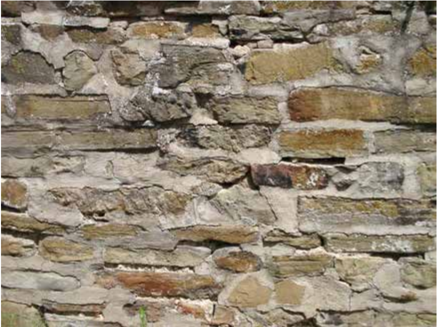
Figura 8. Madre di Dio. Dettaglio della muratura ricostruita della 'III fase' – narteca (2005).
