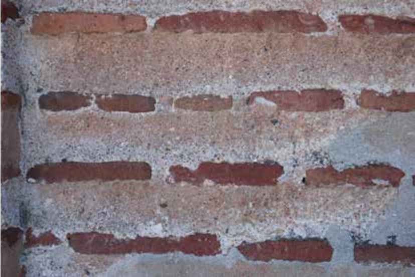
Figura 24. San Nicola. Muratura della 'I fase'. Dettaglio del muro nord dell'aula centrale (2005)
