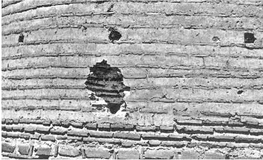
Figura 89. La tecnica delle murature in mattone nascosto, mura della città di Nicea (da Mango 1978)
