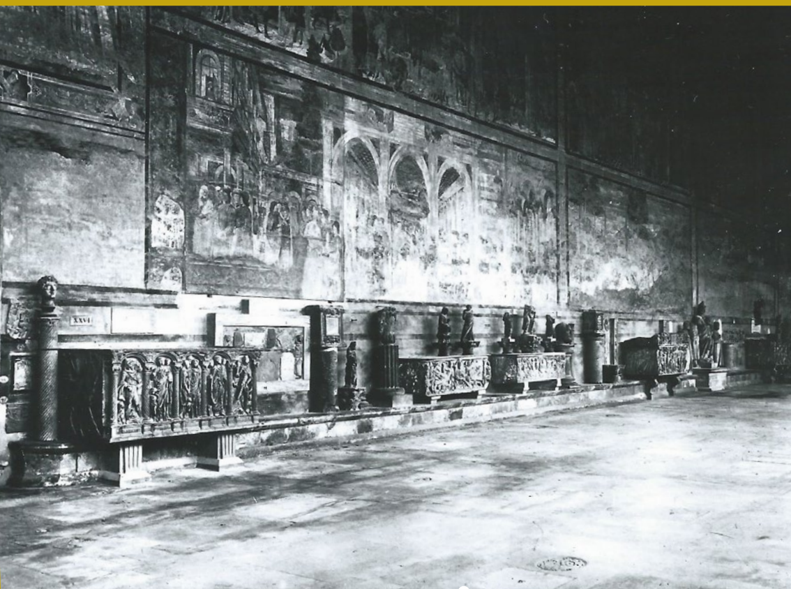
CORRIDOIO NORD DEL CAMPOSANTO MONUMENTALE DI PISA CON IL PANNELLO DELLE ANTICHITÀ EGIZIE
