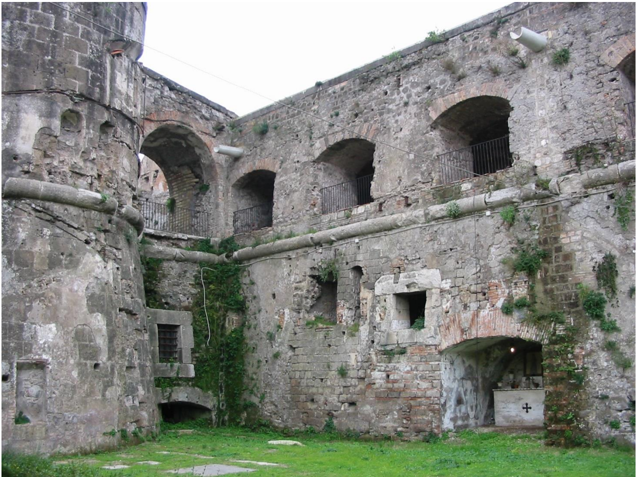
Fig. 8 - Particolare dell'innesto del bastione con il blocco di collegamento, lato sud-ovest, 2004
