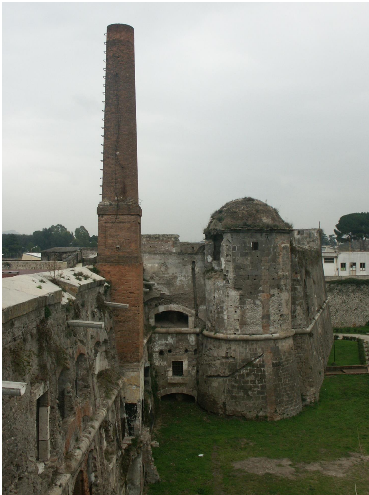
Fig. 10 - Particolare del corpo di fabbrica verso sud-ovest, in primo piano la ciminiera aggiunta all'atto della trasformazione in Pirotecnico, 2004.
