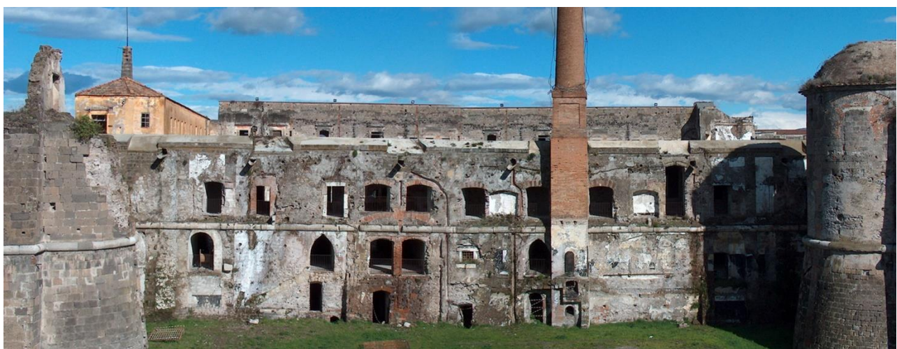
Fig. 9 - Il corpo di fabbrica tra i due bastioni vero sud-ovest, 2004.
